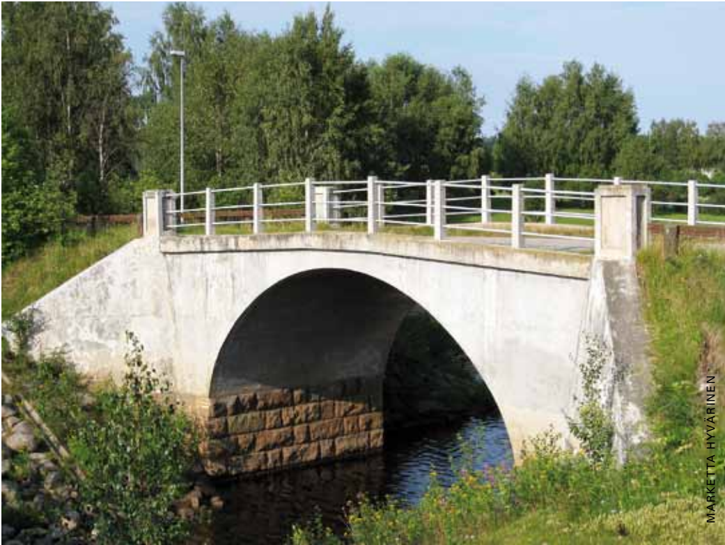
Saarenputaan teräsbetoninen holvisilta Rovaniemellä.
