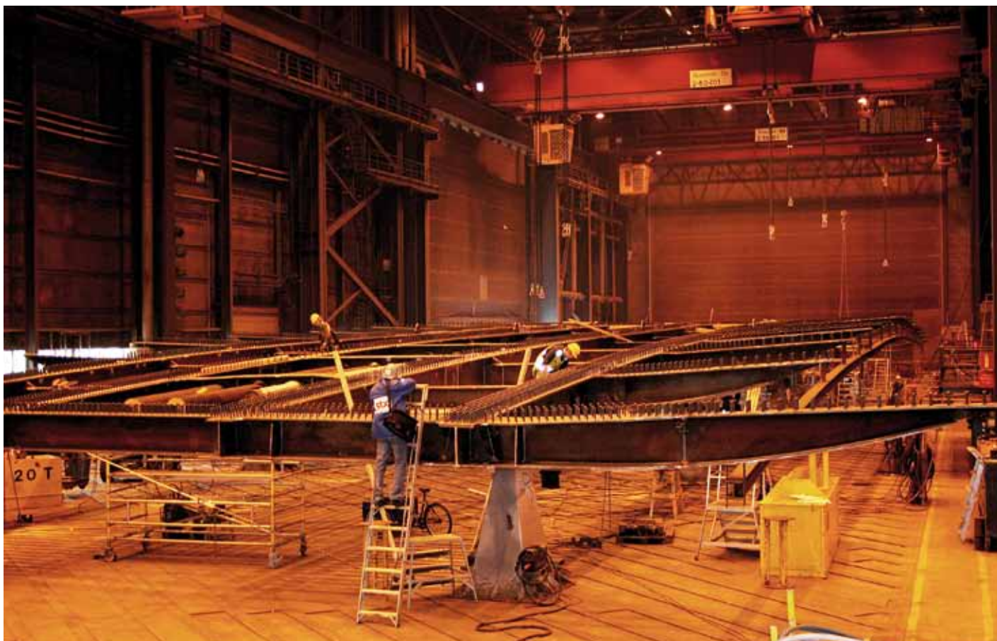
Sillan runko valmistettiin STX Finlandin Turun telakalla, josta se uitettiin paikalleen kokonaisuena.
