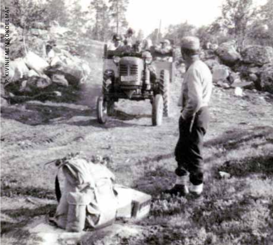
Suuri tieliikenteellinen edistysaskel 130 kilometrin pituiselle liikenneväylälle Inarista Näätämöön 1960-luvun alussa oli, kun 20 kilometrin pituinen tieosuus rakennettiin traktorijokelpoiseksi.
