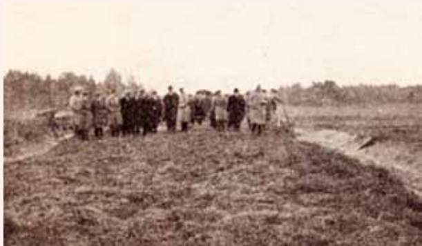
Tiepäivien osanottajat Turku–Rauma maantien työmaalla. Tien eristyskerros tehtiin havuista ja sorasta.
