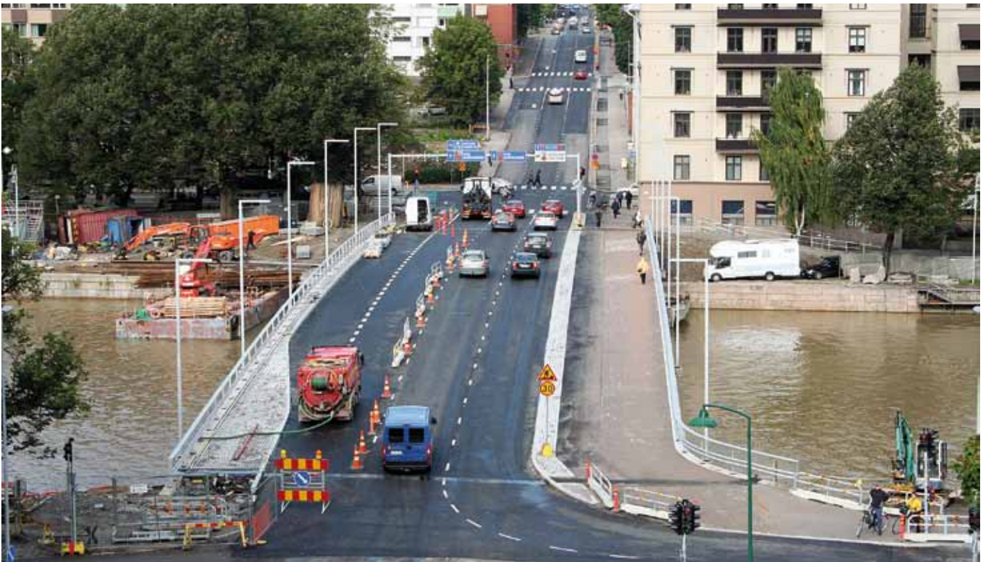
Myllysilta avattiin liikenteelle 19.9.2011 aluksi kaksikaistaisena.
