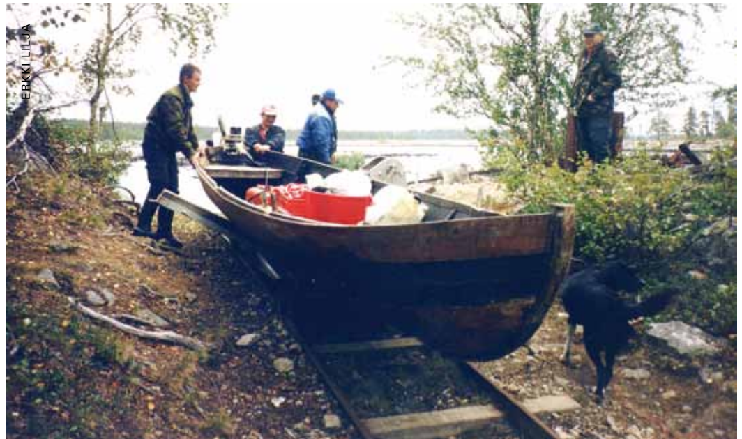
Suolistaipaleen 40 metrin pituinen veneenvetorata on nykyisinkin käytössä. Reitin tärkeyttä osoittaa, että 1905 komiteamietinnössä esitettiin kannakselle rakennettavaksi kanavaa sulkuineen. Suolisjärven ja -vuonon vedenpintojen ero on n. 2,5 metriä.
