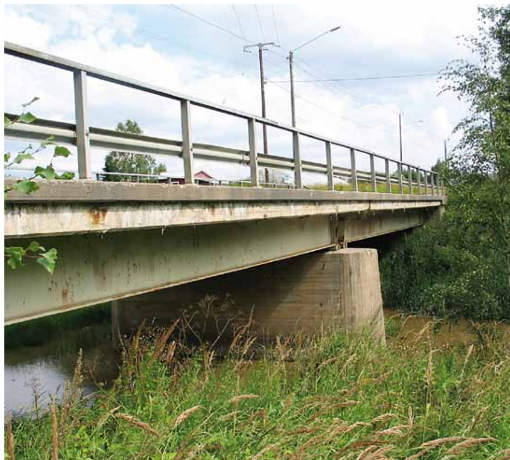
Kuva 3. Tavanomaisessa ympäristössä sijaitseva silta (Ohkolanjoen silta, Mäntsälä).
