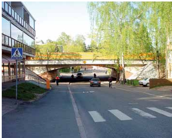
Kuva 2. Vaativassa ympäristössä sijaitseva silta (Tunnelintien silta, Helsinki).
