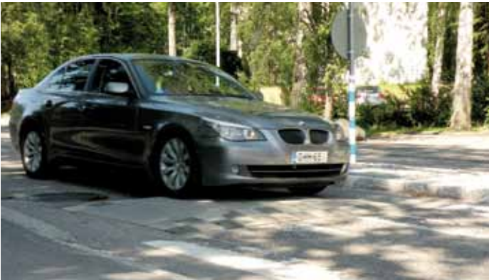
Väärin toteutettu jyrkkäreunainen hidaste alentaa ajonopeutta liikaa ja samalla vaikeuttaa talvikunnossapitoa.
