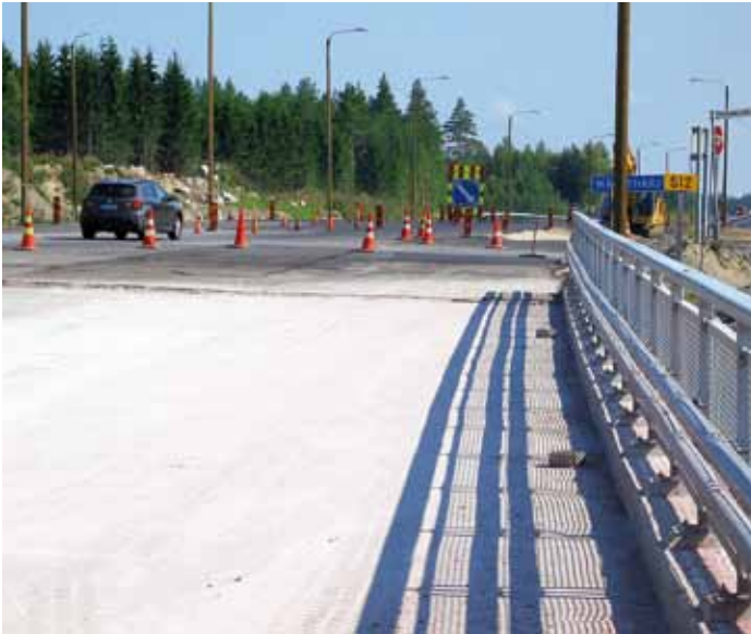
Kiertoteitä ja tilapäisiä liikennejärjestelyjä on kuulunut hankkeeseen runsaasti.
