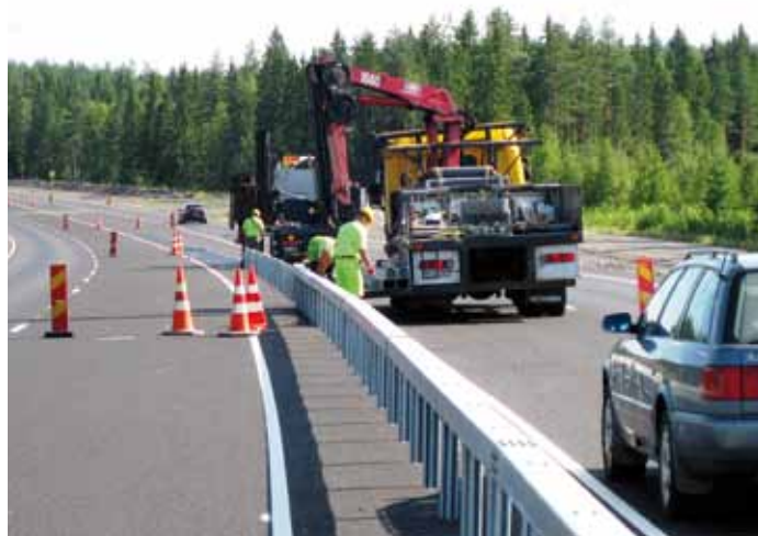
Keskikaista estää kohtaamisonnettomuuksia. Kaiteen asennustyöurakasta vastaa Kanerva Oy.
