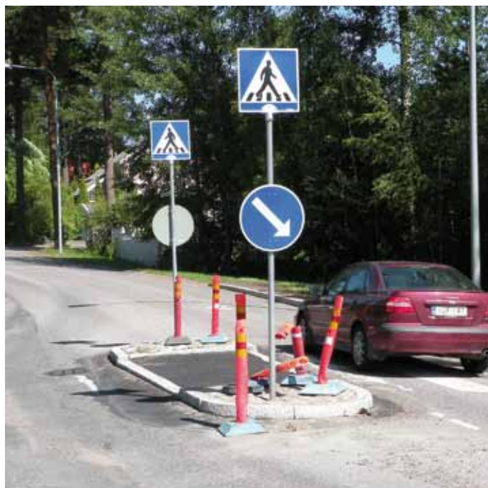
Saarekkeen näkyvyyteen ja tien linjaukseen tulee kiinnittää erityistä huomiota, jotta turhilta vahingoilta vältytään.
