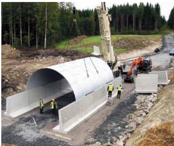
Kousalan risteyssillan asennus.
