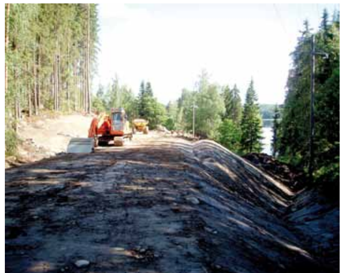
Leikkauksesta saatavilla maa-aineilla saatiin tien pohjara- kenteet rakennettua.
