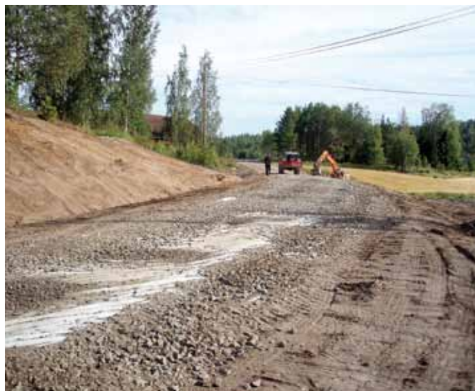
Uusi tie saatiin suoraan ohi koko talouskeskuksen. Tarvittavaa täyttöä penkereen rakentamiseen saatiin tiessä olevaa mäkeä madaltamalla. Sähkö ja puhelinjohtoja jouduttiin siirtämään. Uusi tieosuus 150 metriä.
