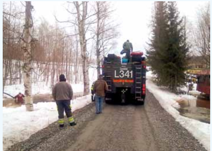
Puolustusvoimat aloittavat puron tyhjennyksen. Sukeltaja yrittää etsiä rumpuputken päitä vedestä.
