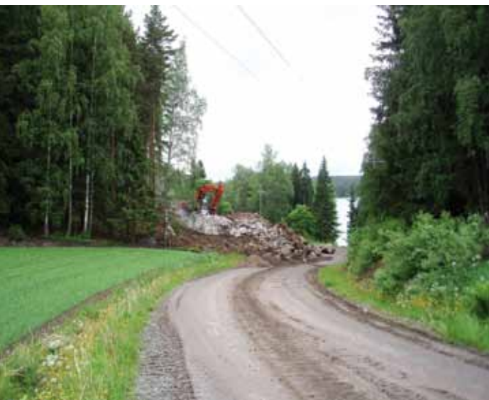
Mutka ja syvä rotko: Mittava leikkaus vuoren rinteelle pois- ti vaarallisen mutkan ja rotkon kokonaan.
