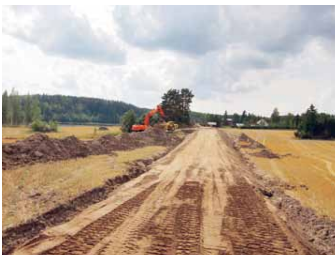
Pelloilta kuorittiin ruokamulta pois ja se käytettiin vanhan tieosuuden muuntamisessa pelloksi. Täytössä käytettävä moreenimaa saatiin läheltä kiinteistön omalta alueelta.
