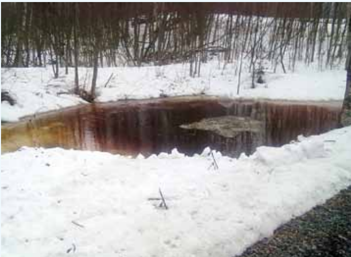
Syy veden nousemiseen oli puolustusvoimien kerosiiniputkien alla olevien rumpujen jäätyminen.
