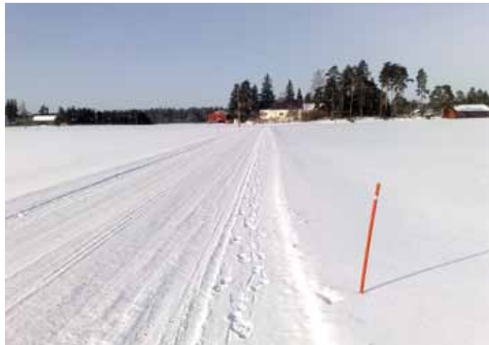
Ajoradan pintaa nostettiin peruskorjauksen yhteydessä 0,3 metriä ja lumi pakenee tuulen ansiosta. Tien reunat on merkittävä selvemmin.
