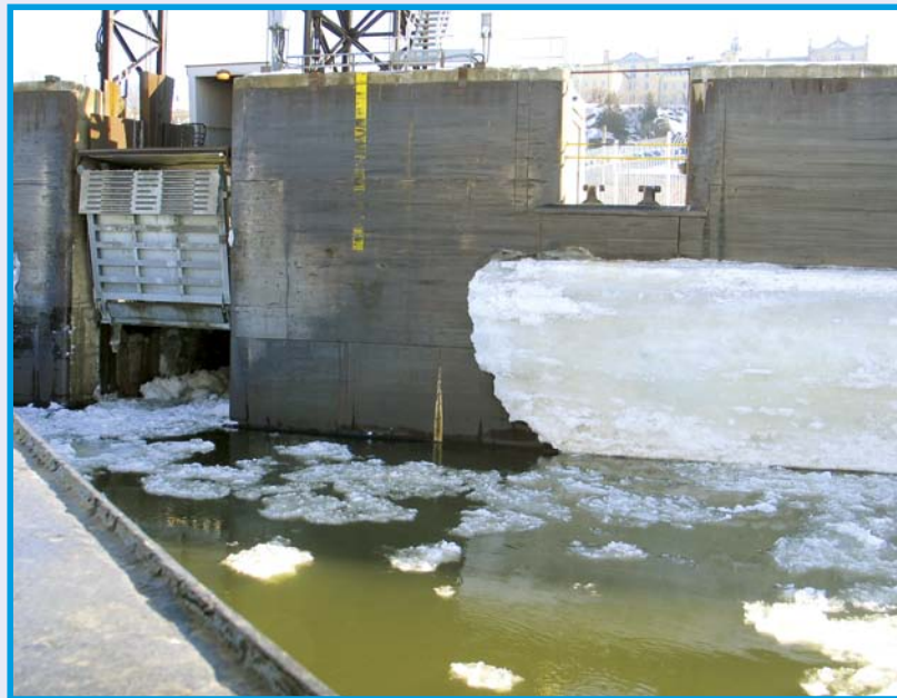
Jää pakkautuu helposti laiturirakenteita vasten voimakkaan virtauksen ja tuulen takia. Siksi osa rakenteista on varustettu sähkövastuksilla.
