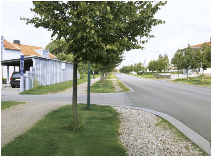
Katujen reunakivet ovat asfaltin pinnan tasossa ja päästävät hulevedet imeytymään sorauomaan. Helsingborg, Mariastad.
