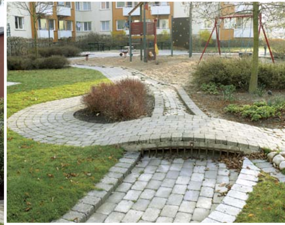
Hulevesi on otettu mukaan leikkiin. Leikkipaikan kohdalla uoma on jyrkkä, ja sen pohjaan sijoitetut kivet saavat veden solisemaan. Voi kuvitella, että lapset viihtyvät sateellakin ulkona. Malmö, Augustenborg.
