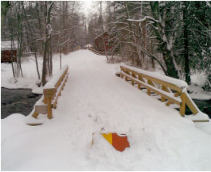
Jos tie ei ole ajoneuvojen käytettävissä tai sillä on kantavuusrajoitus esim. sillalla, siitä tulee kertoa hätäilmoitusta tehtäessä.
