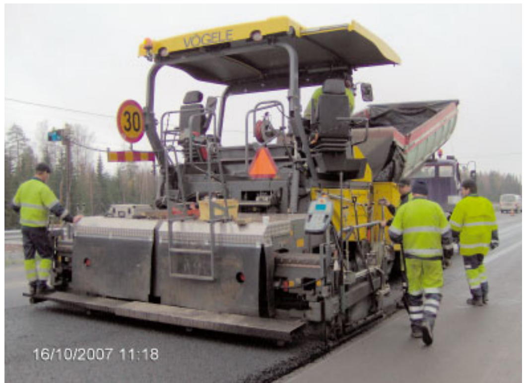
Asfalttimassan purkutapahtuma käynnissä levitinpäässä (Tampere, Oulun yliopisto, Juha-Matti Halme).
