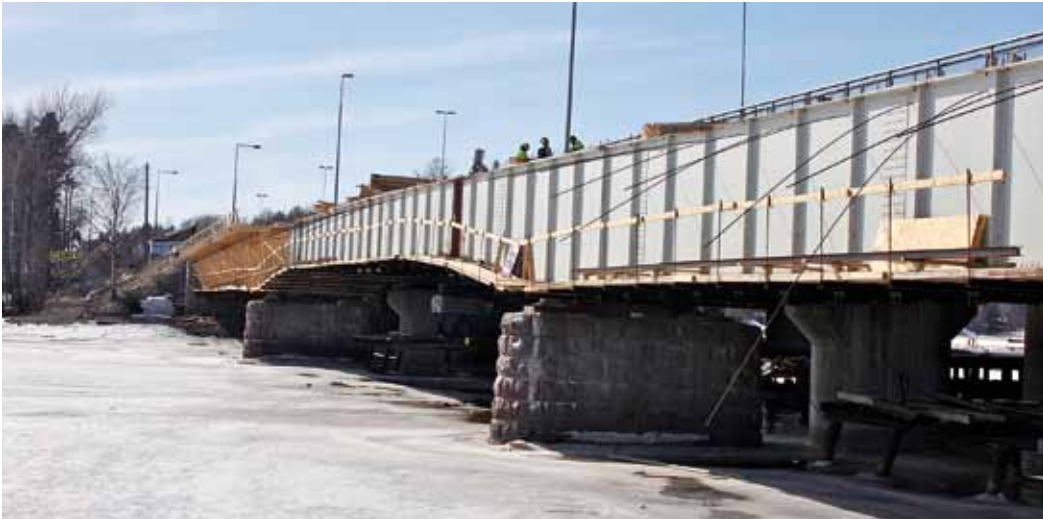
Suojellun Muulon sillan korjaus on jäljellä olevista töistä suurin. Silta on vuodelta 1937.
