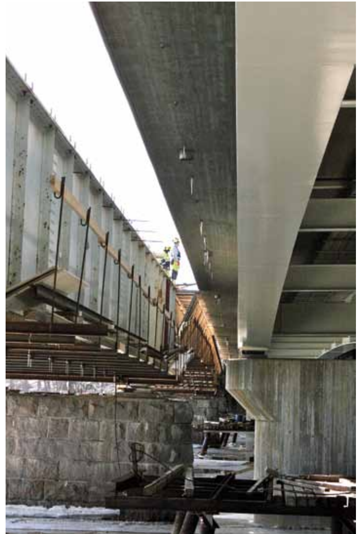
Muulon silta ja uusi paikallisliikenteen silta alapäin.
