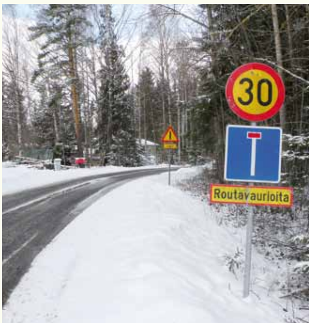
Onko tie tarkoitustaan vastaavassa kunnossa?
