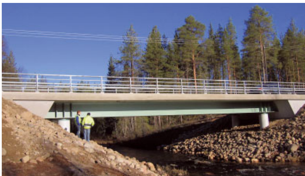
Laisentianjoen sillan toteuttamisessa käytettiin useita edistyksellisiä teknisiä ratkaisuita.
