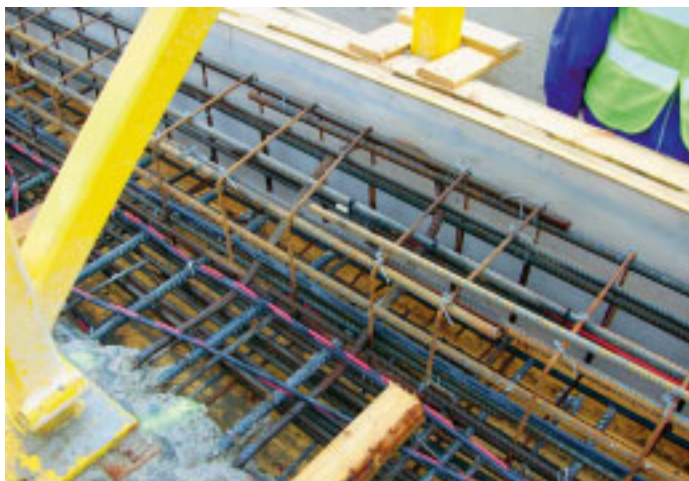
Kosteusantureiden ja optisten kuitujen asennus Boxbyn sillaan ennen kannen valua.
