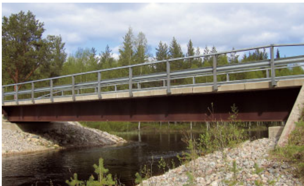
Säänkestävästä teräksestä valmistettu tyyppisilta.
