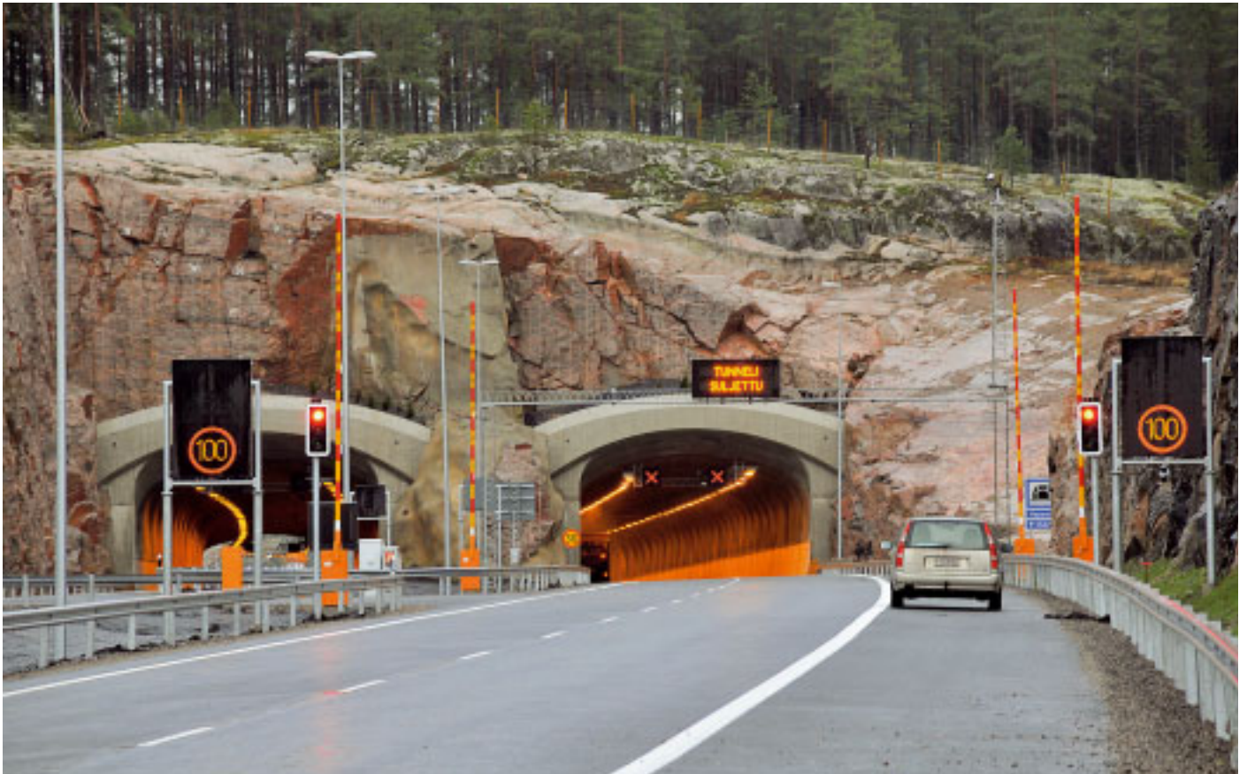
Kuva vuoden 2008 syksyltä, jolloin testattiin Hepomäen tunnelin kaistaopasteiden toimintaa tunnelin sulkutilanteissa.
