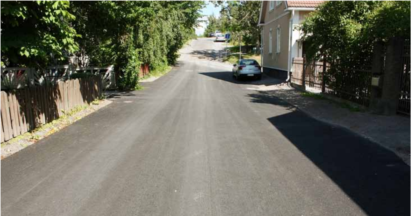
Biofluksilla elvytetyllä uusioasfalttimassalla päällystetty koekohte oli moitteettomassa kunnossa 10 viikkoa päällystysten jälkeen. Koekohteen seuranta on tarkoitus jatkaa talven jälkeen.
