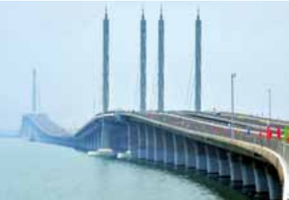
Kiinan ja maailman pisin silta ylittää Jiaozhoun lahden Etelä-Koreaa vastapäätä.
