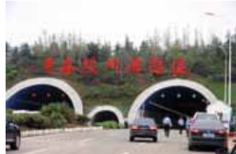
Jiaozhoun sillan parina toimivaa 10 km:n tunnelia avataan. Huomaa huoltotunneli ajoratojen välissä.
