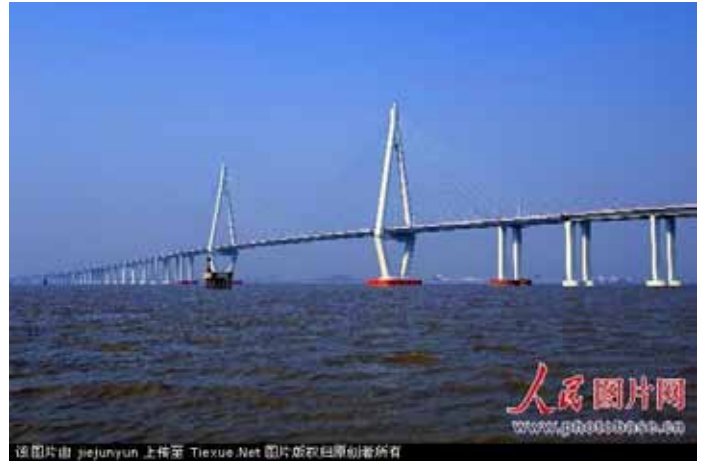
35,6 km pitkä Hangzhoun lahden silta on tyypillinen Kiinan uusi jättiläissilta. Kaupunki sijaitsee Shanghaiin eteläpuolella, ja silta yhdistää Shanghaiin Ningbon satamakaupunkiin. Silta valmistui 2008 ja maksoi 1,1 mrd. euroa.
