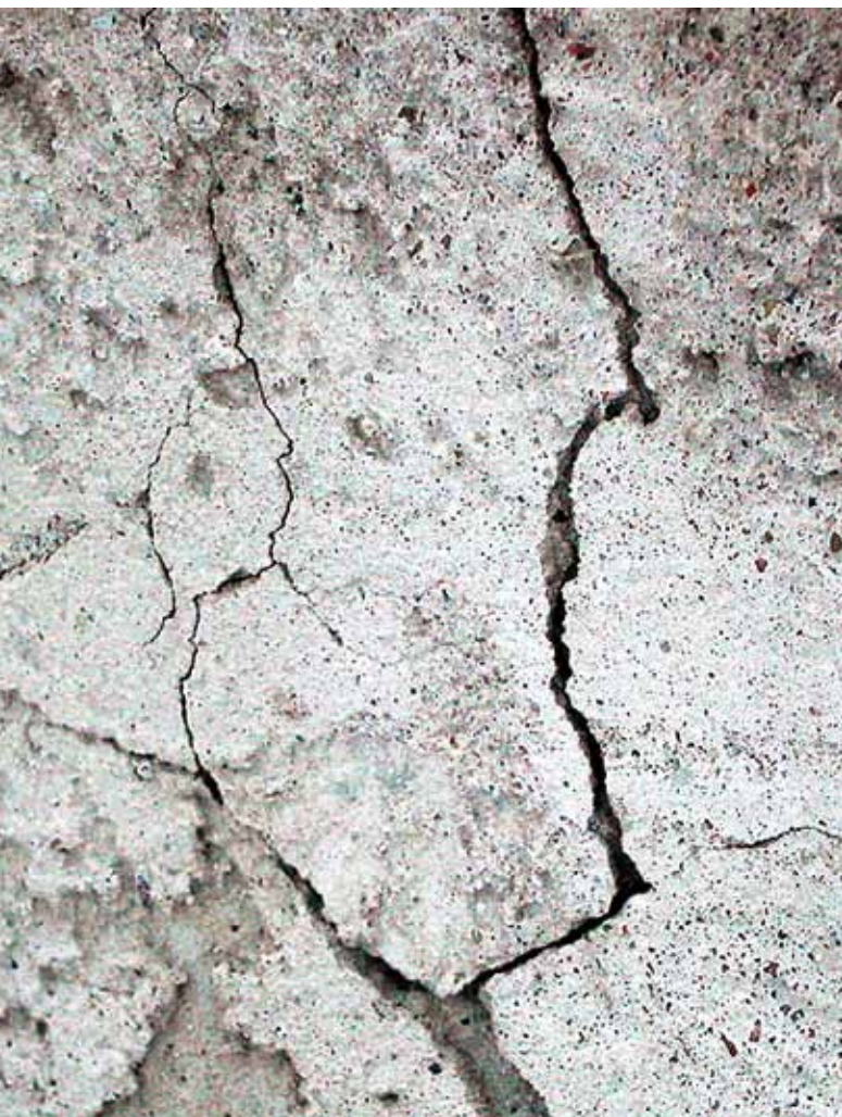
Pakkasella vesi voi siirtyä paikasta toiseen valevesipintoja pitkin. Tapahtuu rapautumista ilman näkyvää vettä.
