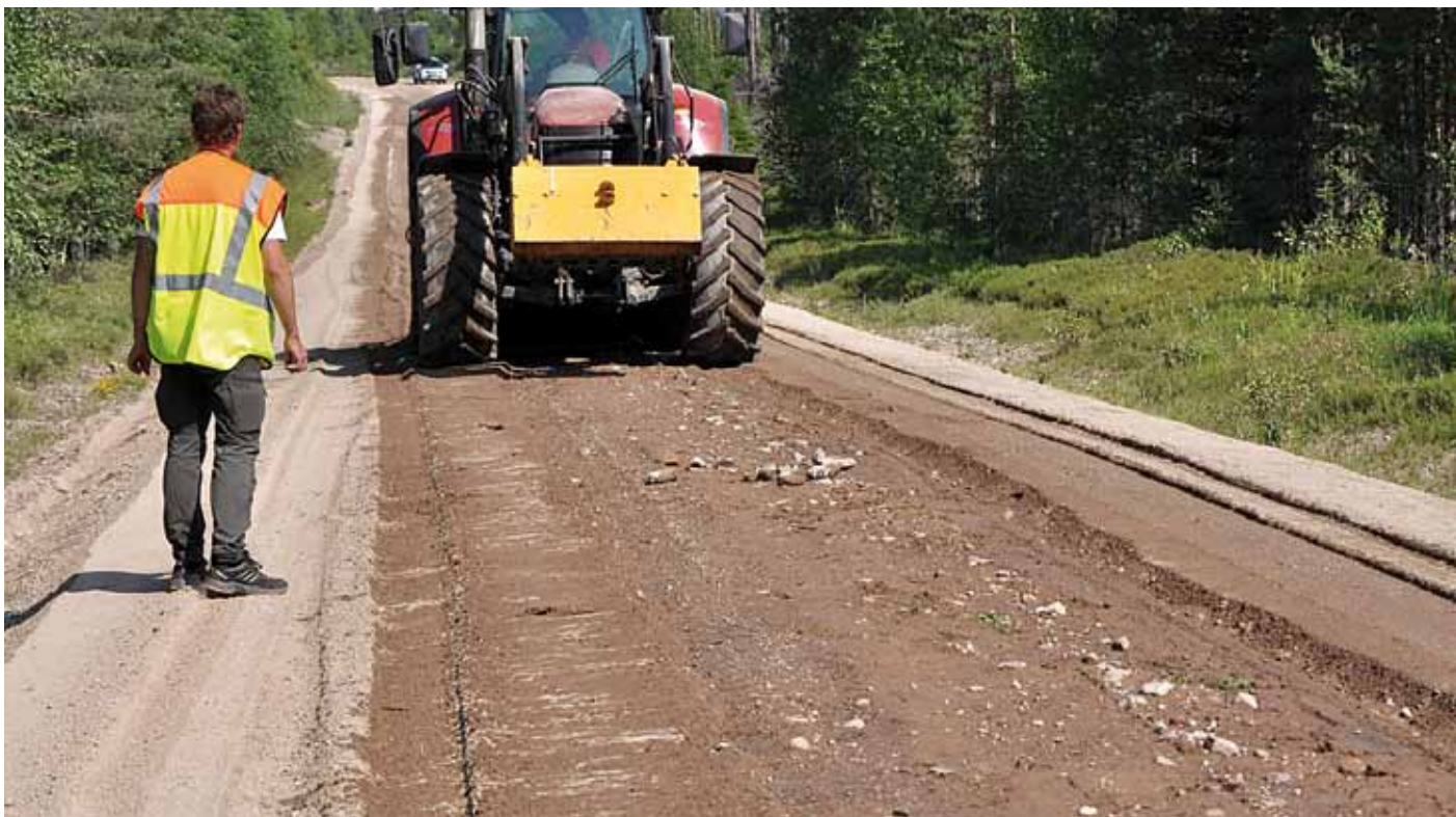
Käsittely kivijyrsimellä noin 10 cm syvyydeltä tiehöylällä harattua ja muotoiltua tienpintaa myöten. Lisäkiviaines on ajettu tielle aiemmin.
