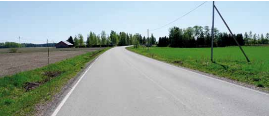
Kuva 1: Elimäen koetie toukokuussa 2010 (biofluksattu bitumi sideaineena vasemmanpuoleisella ja V1500-bitumi oikeanpuoleisella kaistalla).
