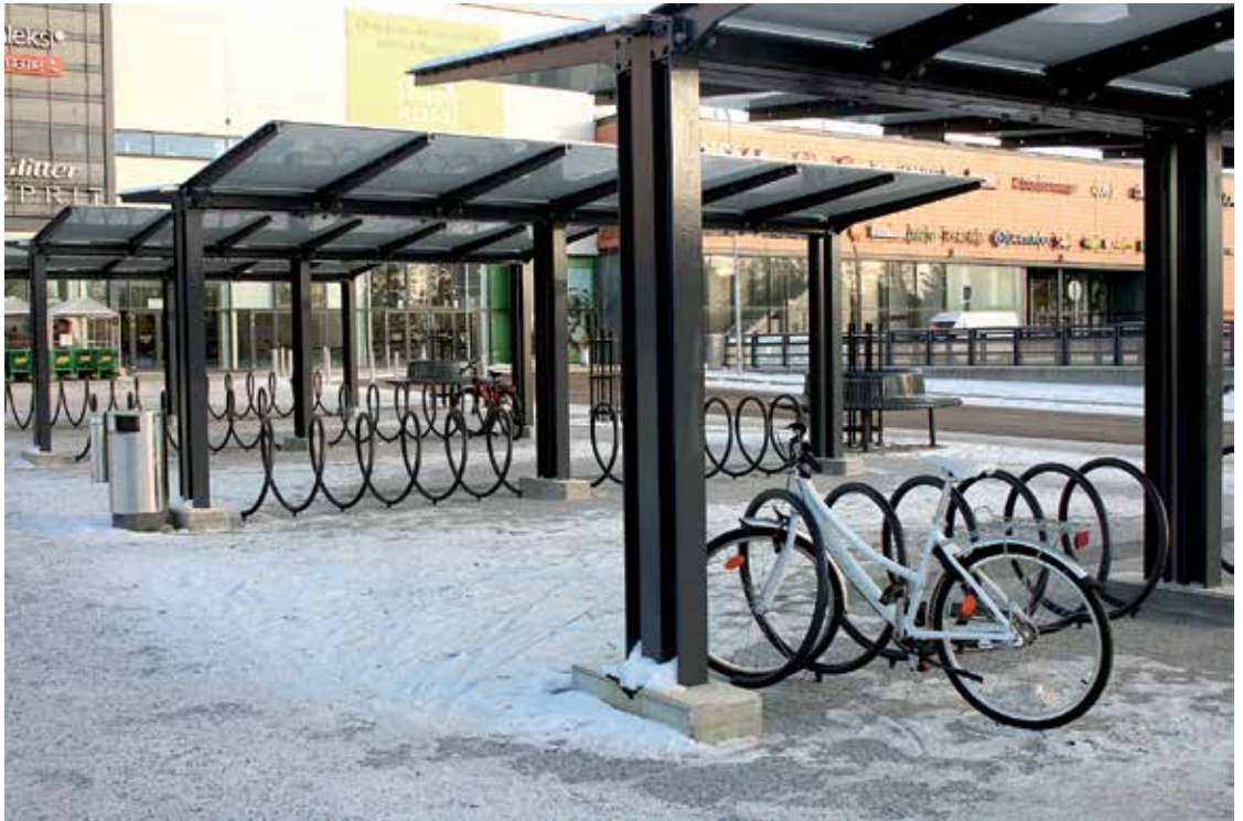
Pääsisäänkäynnin eteen on sijoitettu katetut pyörätelineet, joihin onnistuu tavarapyöränkin pysäköiminen.
