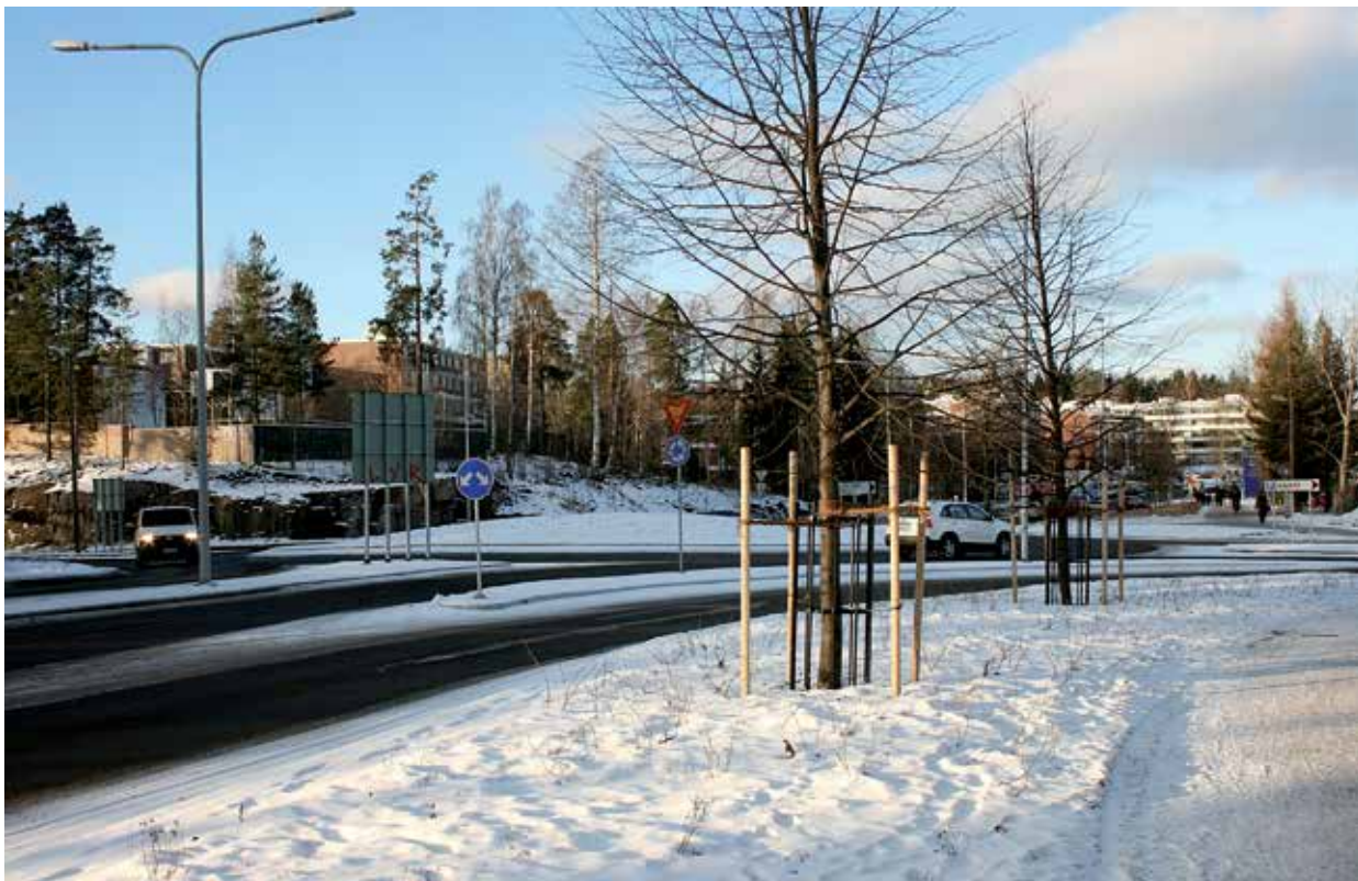
Kauppakeskukseen kääntyville rakennettiin kiertoliittymän ohittava vapaa oikea kaista, mikä on parantanut kiertoliittymän toimivuutta.
