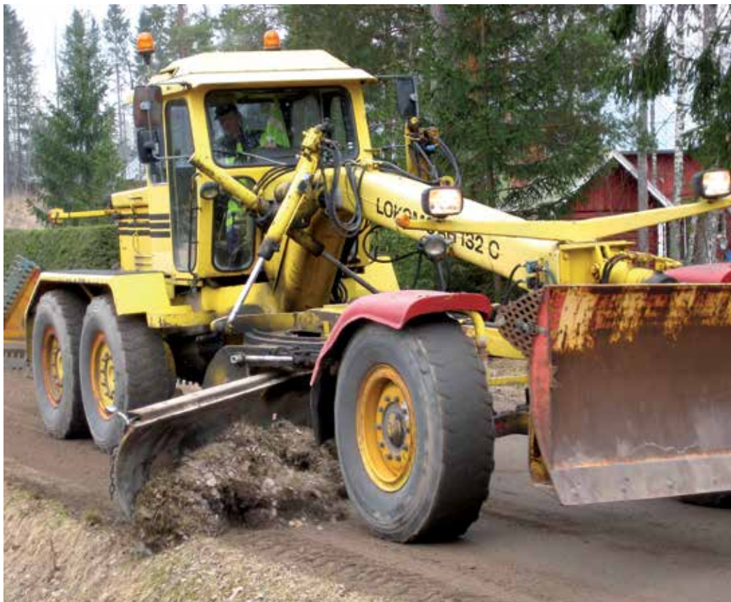
Tien muotoilu ja reunapalteiden poisto onnistuu hyvin vanhallakin tiehöylällä, uudemmalla tietysti entistä paremmin.
