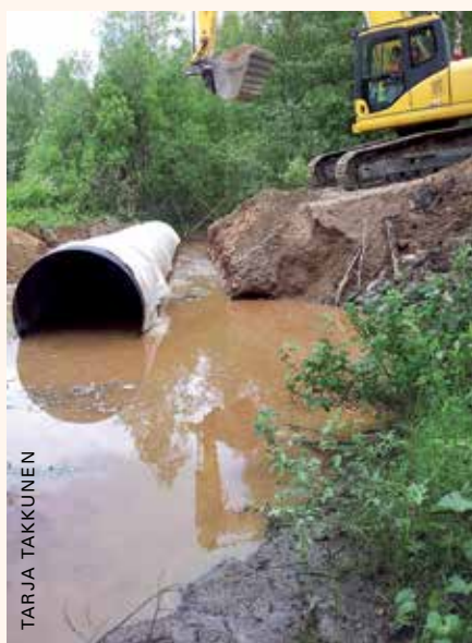
Lupa-asiat on selvitettävä ennen kaivutyöhön ryhtymistä.
