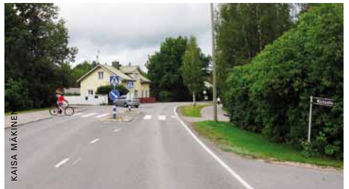
Suojatien keskisaarekkeelle sijoitetut suojatiemerkit erottuvat erittäin hyvin.
