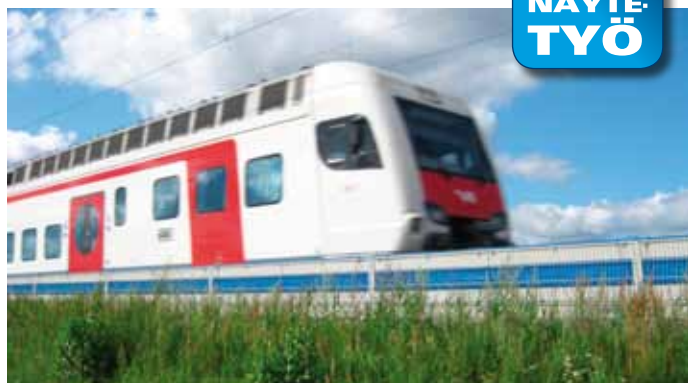
Suomessa koekäytössä oleva matala melueste pääradan varrella Tuusulan Kytömaalla.
