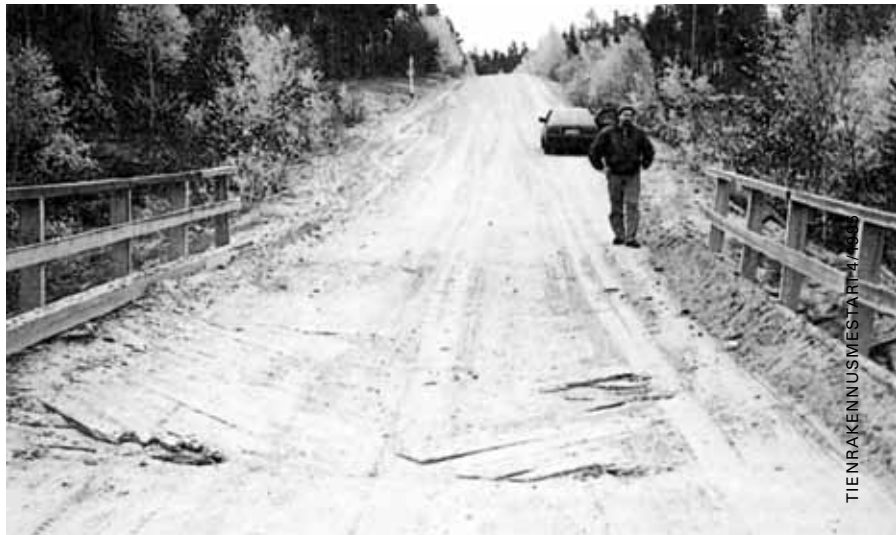
Tuulomantien vuonna 1961 rakennettu silta kuvattuna 36 vuotta myöhemmin.
