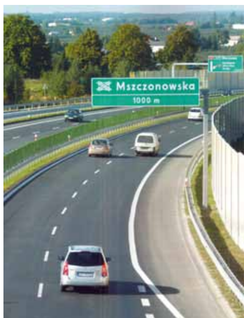
Puolan nimiä on vähän vaikea ääntää, kun slaavilaista kieltä kirjoitetaan latinalaisin aakkosin. Szcz äännetään kuten keskiosa sanasta pushchair. Huomaa häikäisysojalla korotettu keskikaide.
