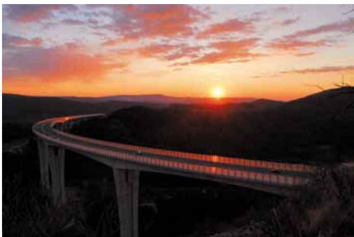
Cerni Kalin viadukti vie Ljubljanasta alas Adrianmerelle.
