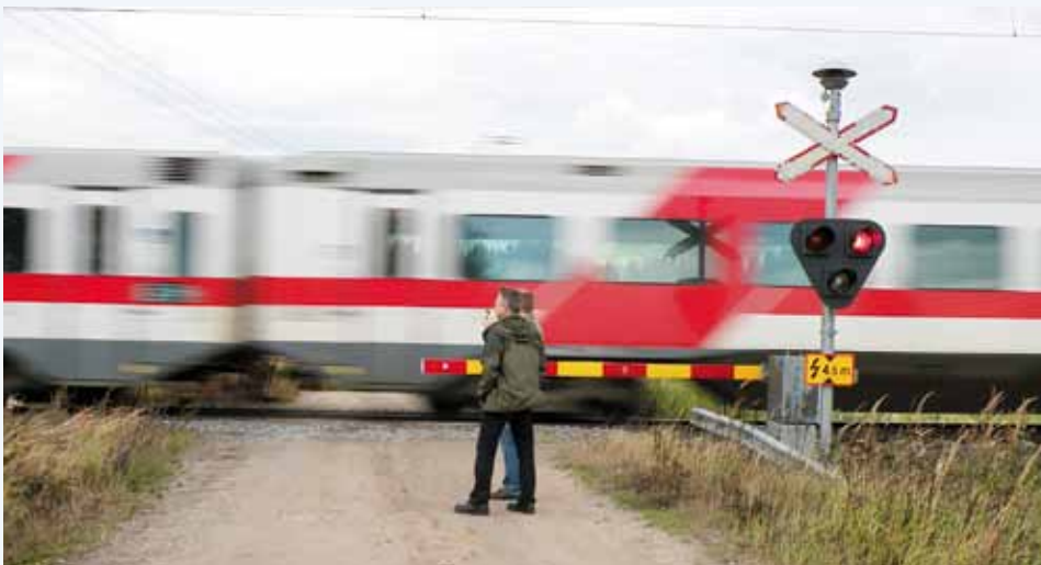
Sulku- ja varoituslaittein varustettu yksiraitainen rautatien tasoristeys.
