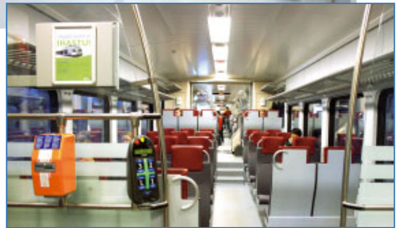
Junan valoisisissa sisätiloissa on ilmastointi.
