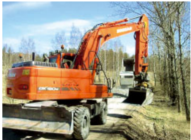
Kantavan kerroksen ajaminen muotoillun pohjan päälle Paraisilla.
