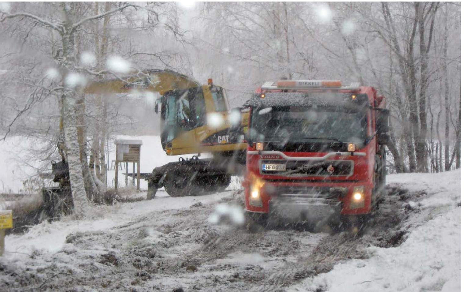
Kaupungin maksamaa kiinteää urakkasummaa voidaan tarkistaa poikkeuksellisten sääolojen takia. Viime talven lumimäärät eivät aiheuttaneet tarkistuksia.
