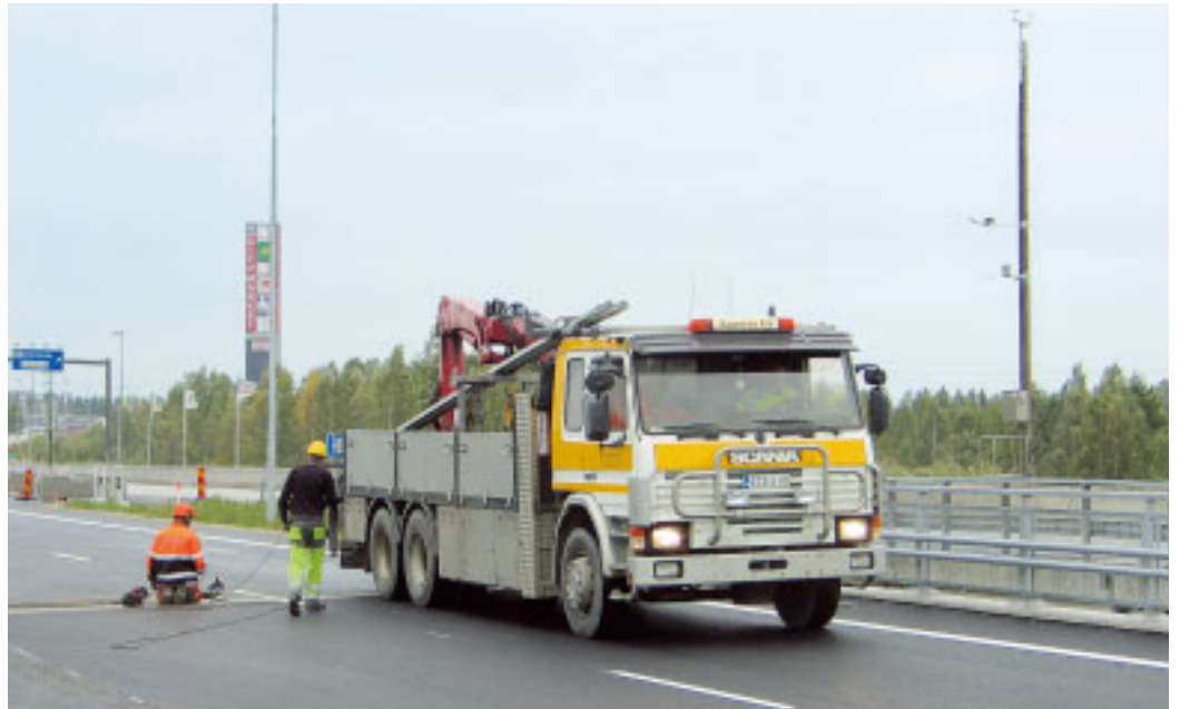
Kaiteiden viimeistelytyöt ja sillan erityistyöt meneillään Kemijoen sillalla.
