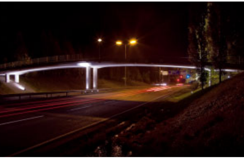
Toinen Tiehallinnon ja Jyväskylän kaupungin yhteistyönä valaisemista "porttisilloista" on nelostien yli kulkeva Mattilanniemen kävelysilta kaupungin eteläpuolella. Valaistus on Annukka Larsenin käsialaa.
