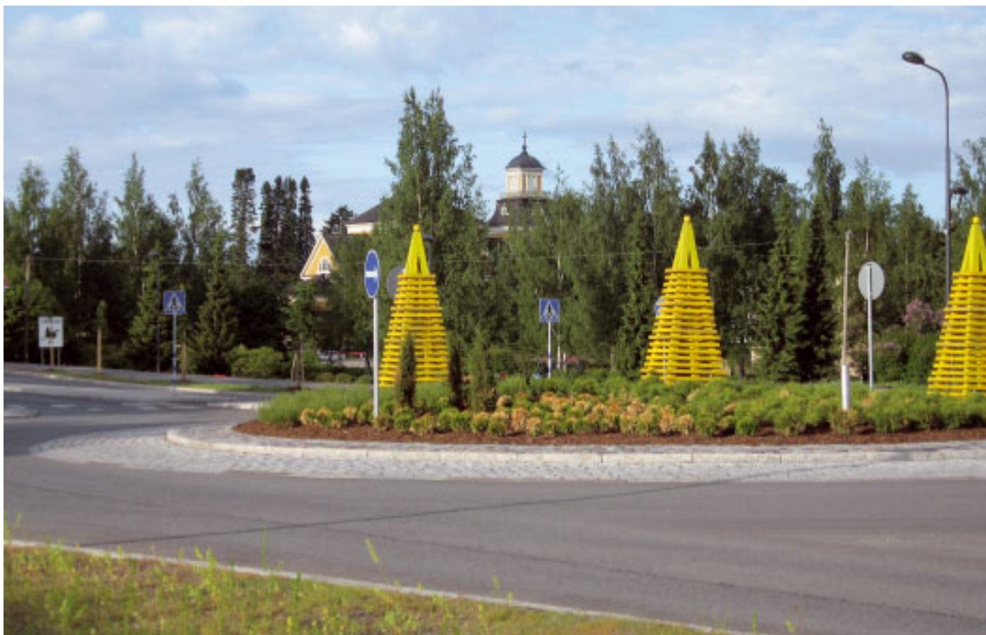
Toinen voittaja on Ylöjärven keskustan tiejärjestelyt. Hankkeeseen sisältyi valo- ja nelibaaraliittymien muuttaminen kiertoliittymiksi, kevyen liikenteen väylien, hidasteiden ja suojatiesaarekkeiden rakentamista.
