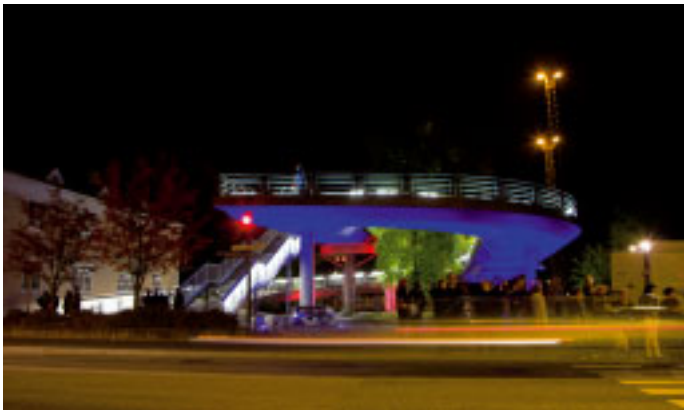
Kilpisenkadun ylikäytäväsillan päätyvalaistus näkyy keskustan kävelykadulle saakka. Aikaisemmin hämärältä ja sokkeloiselta vaikuttanut paikka sai Gad Giladin ja Annukka Larsenin suunnitteleman valaistuksen myötä uuden, raikkaan ilmeen.
