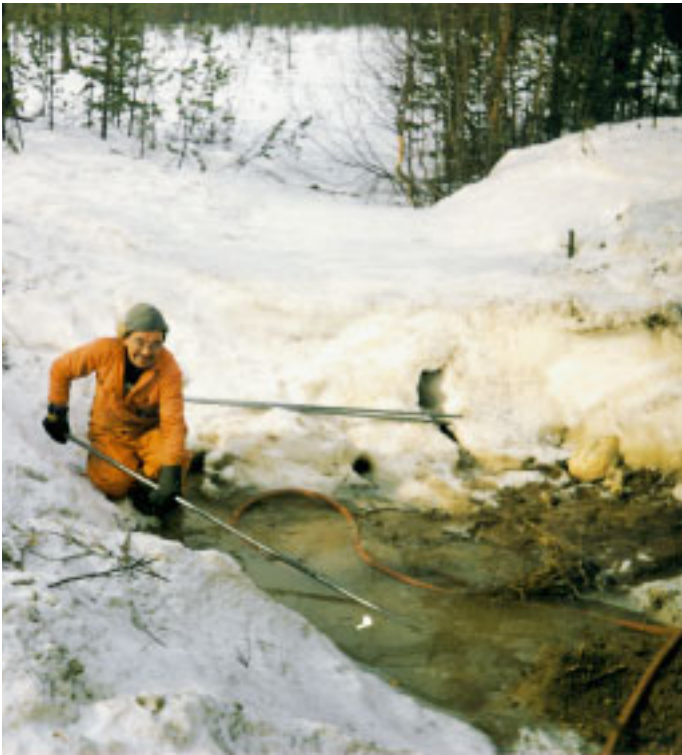
Jäisen rummun sulatusta jossakin Raja-Joosepin tiellä 1986. Höyryputken päässä Nikander Koputoff. (Kuva Raimo Tervo, Ivalo)
