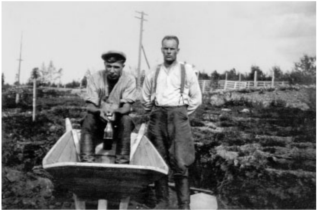
Veikko Lehtisola "ajokissaan" Saariselän Laani- eli Piispanojan siltatyömaalla vuonna 1940. (Kuva otettu Lehtisolan Näpsä-laatikkokameralla)
