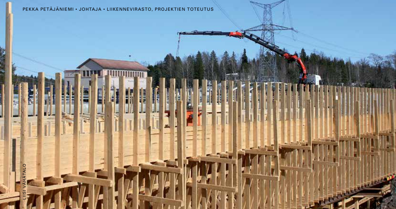
E18 Koskenkylä–Kotka hanke valittiin vuoden rakennustyömaaksi 2013.
