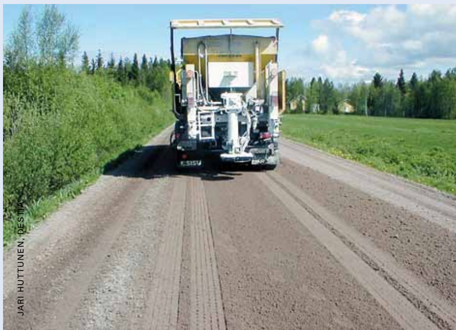
Formiaattien käyttöä pölynsidonnassa on tutkittu vuonna 2012 mm. Oulussa Destian ja Kemiran toimesta.
