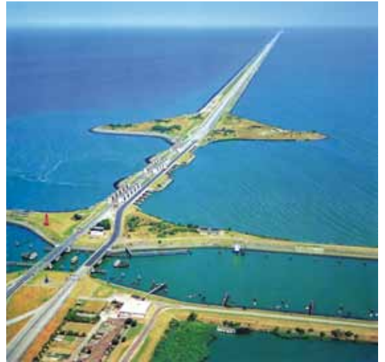
Zuiderzeen suuri pato Afsluitdijk on yksi maailman insinööritöiden näyttöprojekteja. Siinä on kolme sulkua vesiliikennettä varten ja viisi viiden sulun ryhmää vedenpinnan säätelyä varten.
