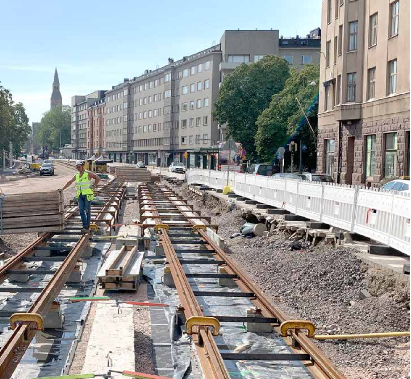
Urakka-alueelle rakennetaan yhteensä 2,6 kilometriä uutta raitiotiekiskoa.
