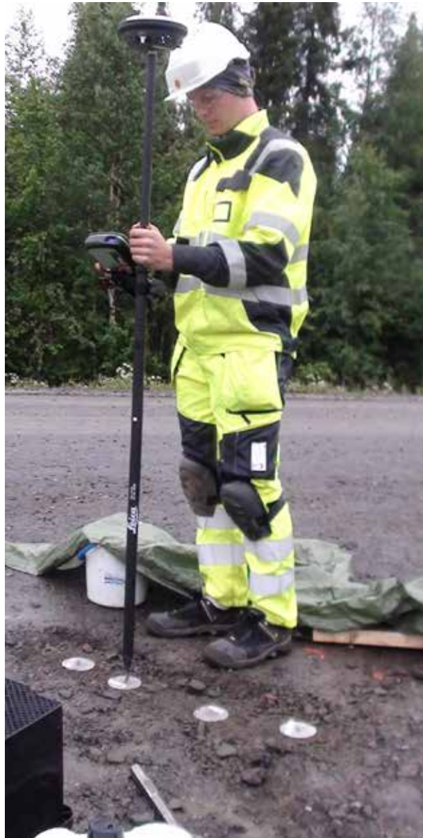
Tierakenteen instrumentointia Aurora-älytiepilottialueella Muoniossa.
