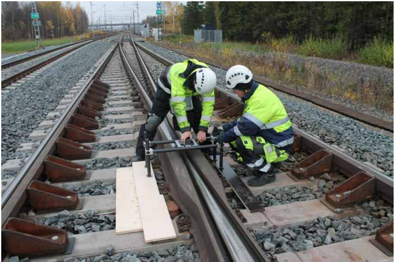
Terran tutkijat mittaamassa rautatievaihteen profiilia.
