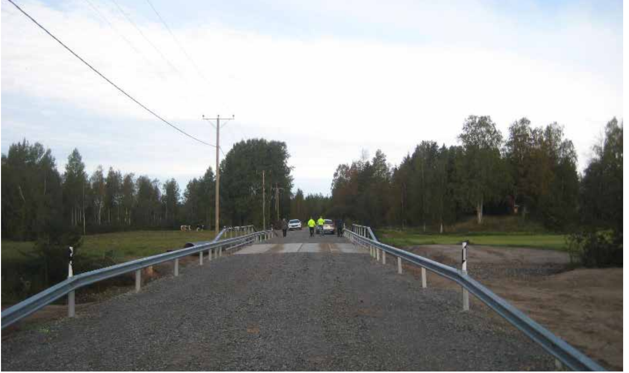
Valmis siltakohde Vaalassa. Tien ja sillan HI= 6,0 m.
