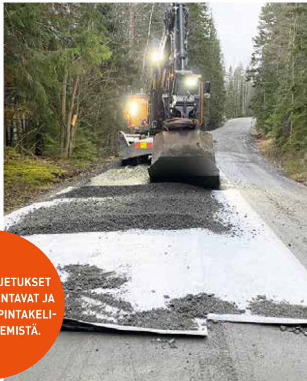
Kuva 2. Koerakentaminen aloitettiin perinteisellä kelirikkokorjausrakenteella.
