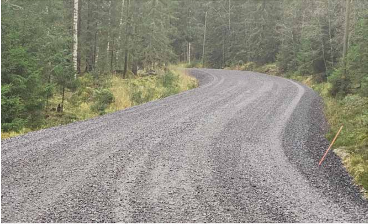
Kuva 4. Yhdistelmälujitteesta ja sepelistä rakennetun koerakenteen päällä pystyttiin liikkumaan työn aikana.
