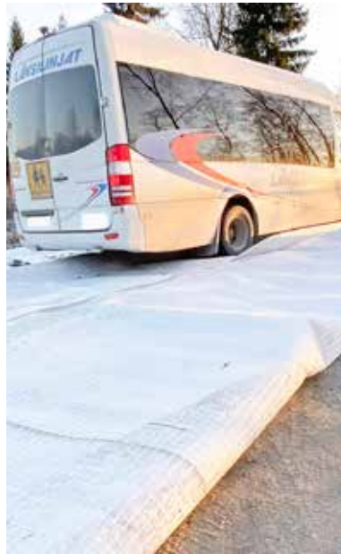
Kuva 3. Salaojamattoja asennettiin koerakenteeseen kaista kerrallaan.
