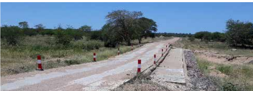
Joskus on helpompaa madaltaa keskilinjaa ja rakentaa betoninen "Irish crossing", jossa tulvaveden annetaan mennä tien yli.
