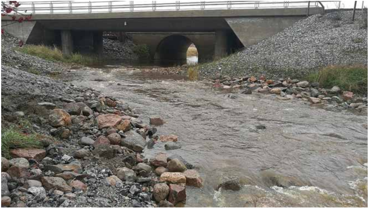
Hirviöjen sillan alueelle rakennettiin luonnonkivestä koskialue.
